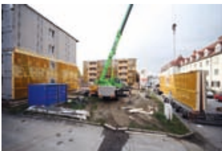
Wandelemente auf Tieflader
