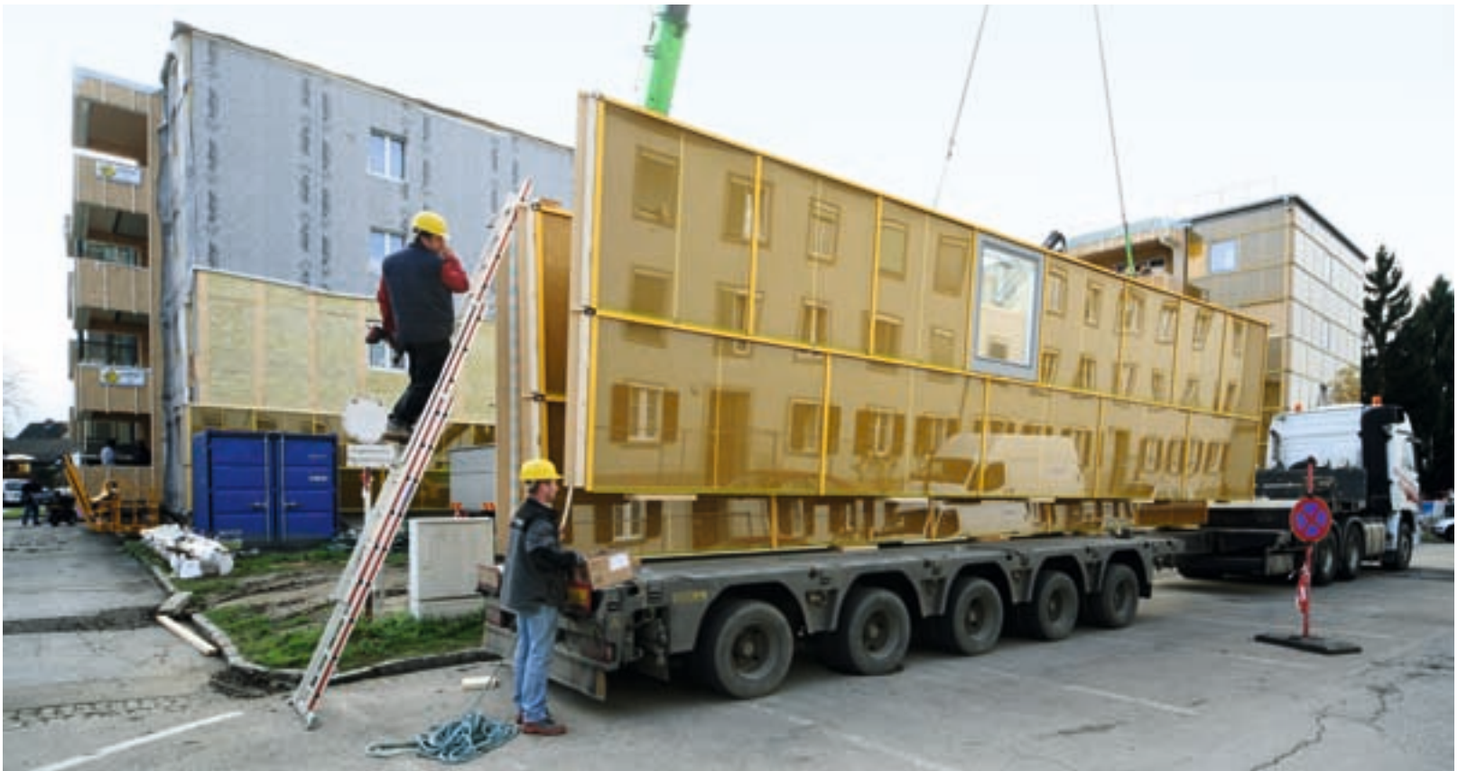
Versetzen einer Elementwand
