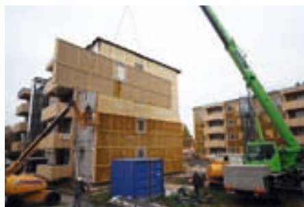
Elementmontage im Stundentakt
