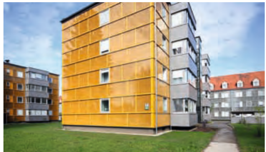
Einzelhäuser (Vordergrund) und lange Zeile (Hintergrund) nach der Sanierung
