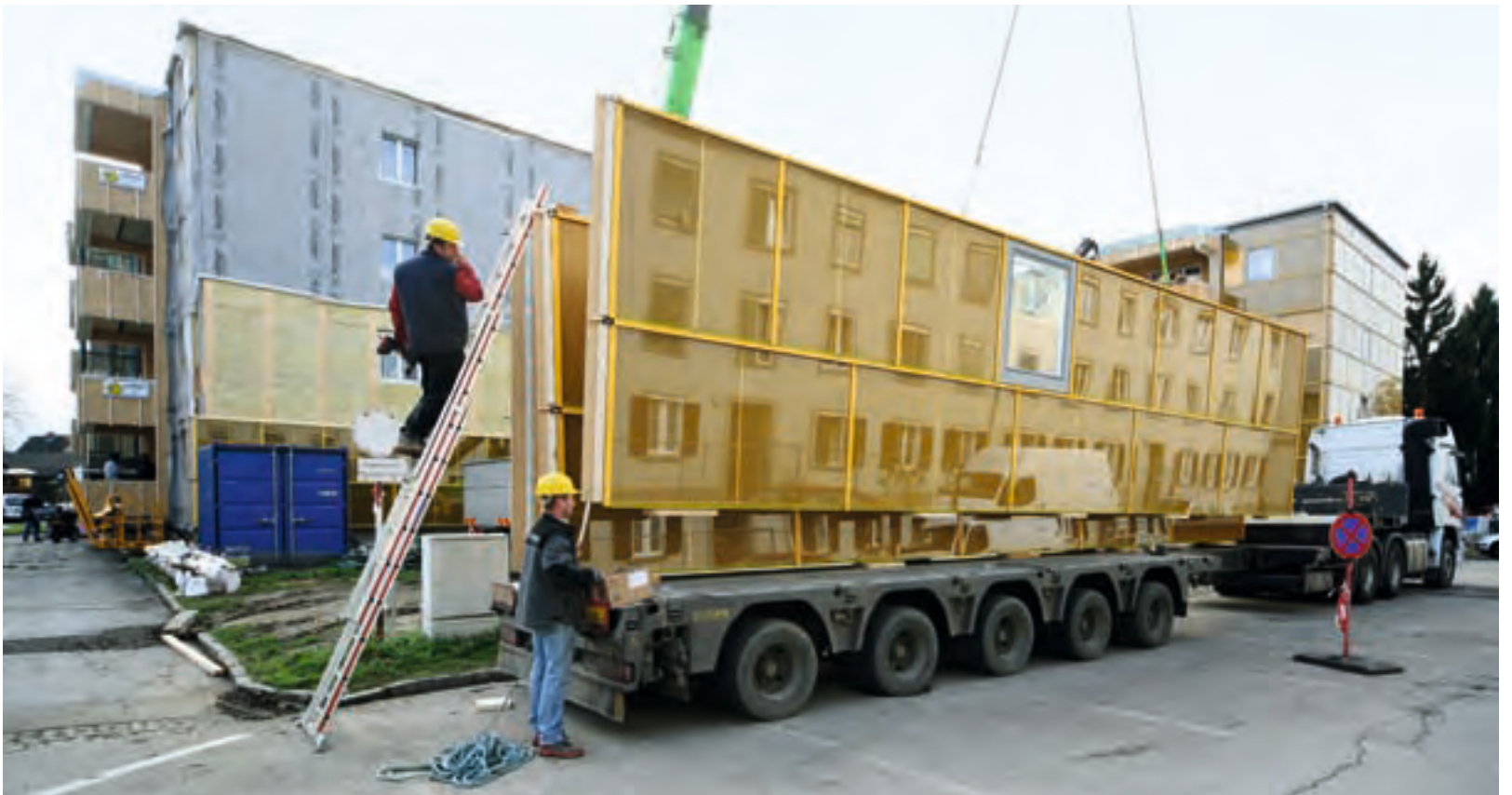
Versetzen einer Elementwand
