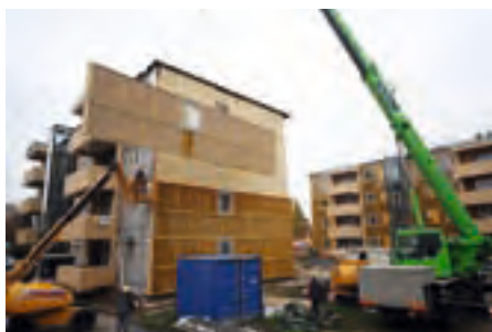
Elementmontage im Stundentakt
