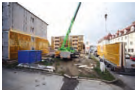
Wandelemente auf Tieflader
