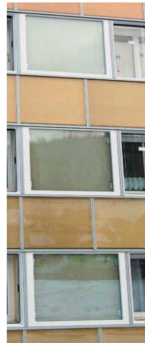
Im Werk fassadenintegriertes Modul WATER:solution & Fixerglasung
