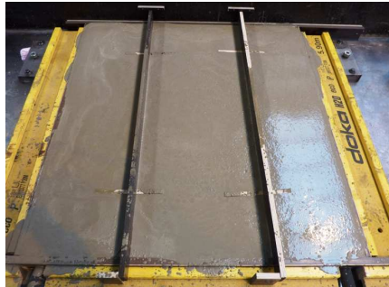
Ausgießen mit Beton
