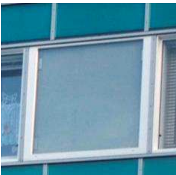
Abbildung: fassadenintegriertes gap-WATER:solution Panel
