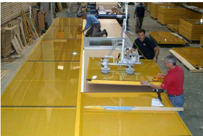
Aufmontage der gap-Paneele & Fenster
